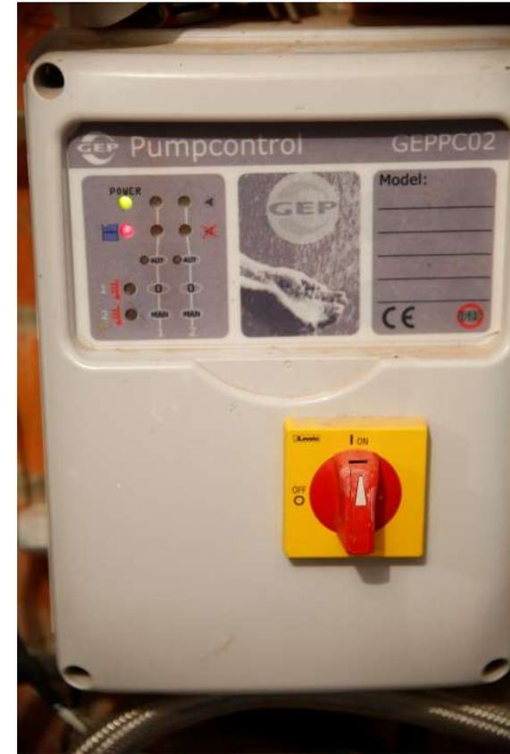
Pumpensteuerung für zwei Tauchpumpen die abwechselnd laufen. Beide Pumpen laufen auf Spitzenleistung. Jede Pumpe wird von der Steuerung überwacht.
